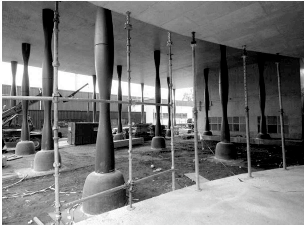
De hoofdingang van het nieuwe ROC, waar een deel van de gietijzeren kolommen al is geplaatst als ode aan de oude gietrij.
