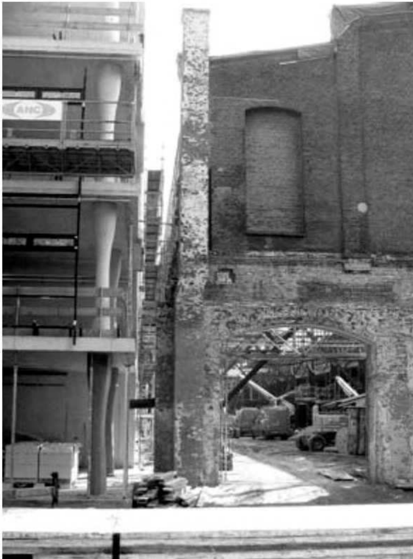
De skeletachtige opbouw van het ROC naast het bijna historische pand waar ooit de gieterij in was gevestigd. foto Han Limburg
