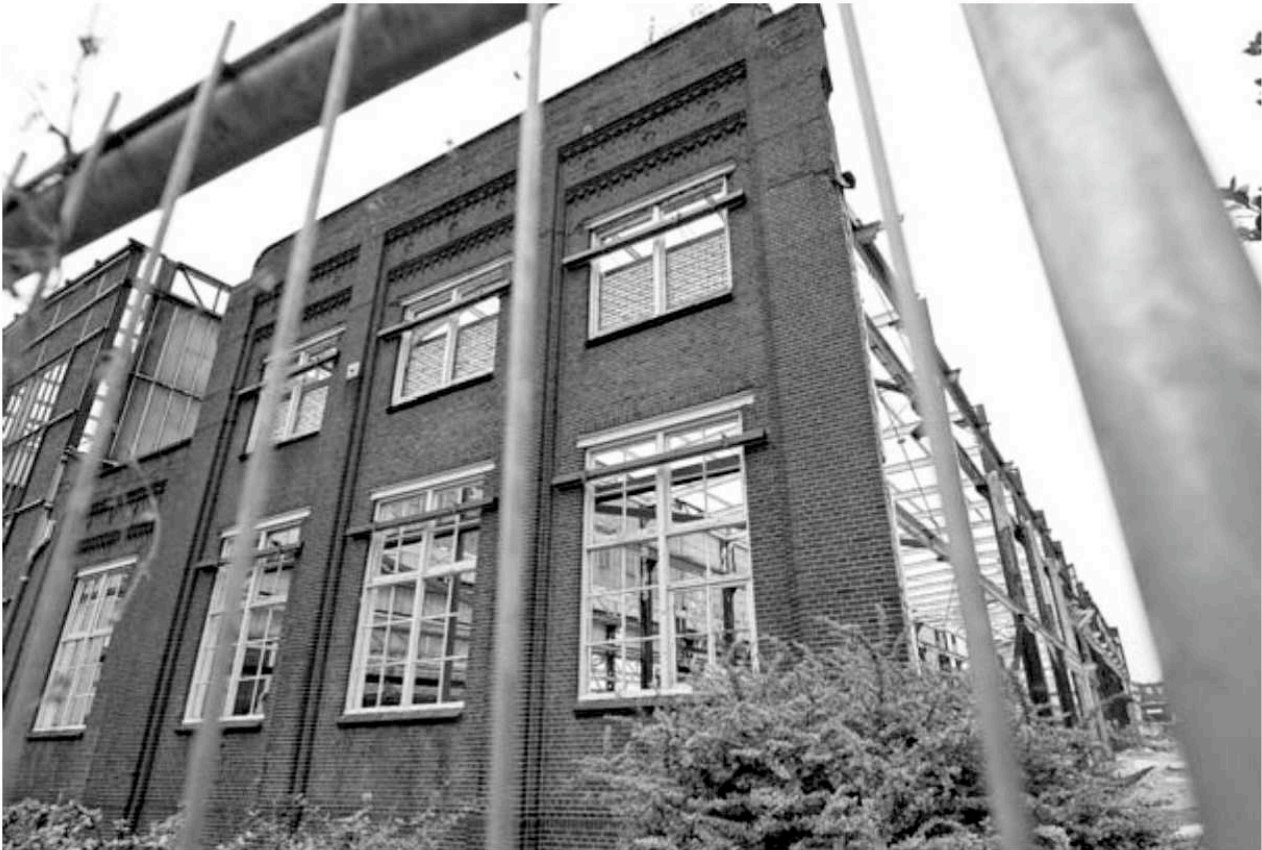
Het Hijschgebouw is een stalen karkas nu de zijmuren verdwenen zijn. Over de invulling is onduidelijkheid, net als over de bouw van de parkeergarage.
