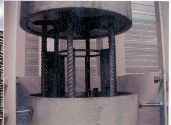
De wapening van de betonknoop die twee helften van een kolom met elkaar verbindt.
